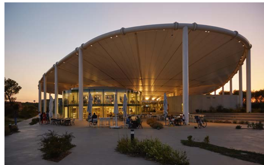
► thecamp à Aix-en-Provence : une canopée de 7 000 m 2 qui abrite des lieux de travail en plein air.
