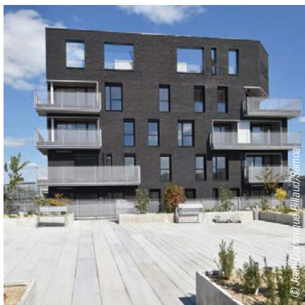
► Immeuble Unik à Nantes, living lab de la french proptech Architectes : Sandra Planchez Maîtrise d'ouvrage : Groupe Realites
