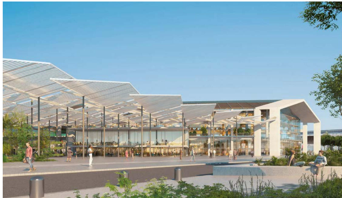
► La Passerelle, futur lieu mixte de 30 000 m 2 travail-loisir-bien-être dans le hangar J1 du port de Marseille
